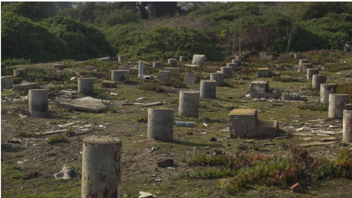
Figura 4 Fotografía estado actual Monumento Histórico Ex Centro de detención
