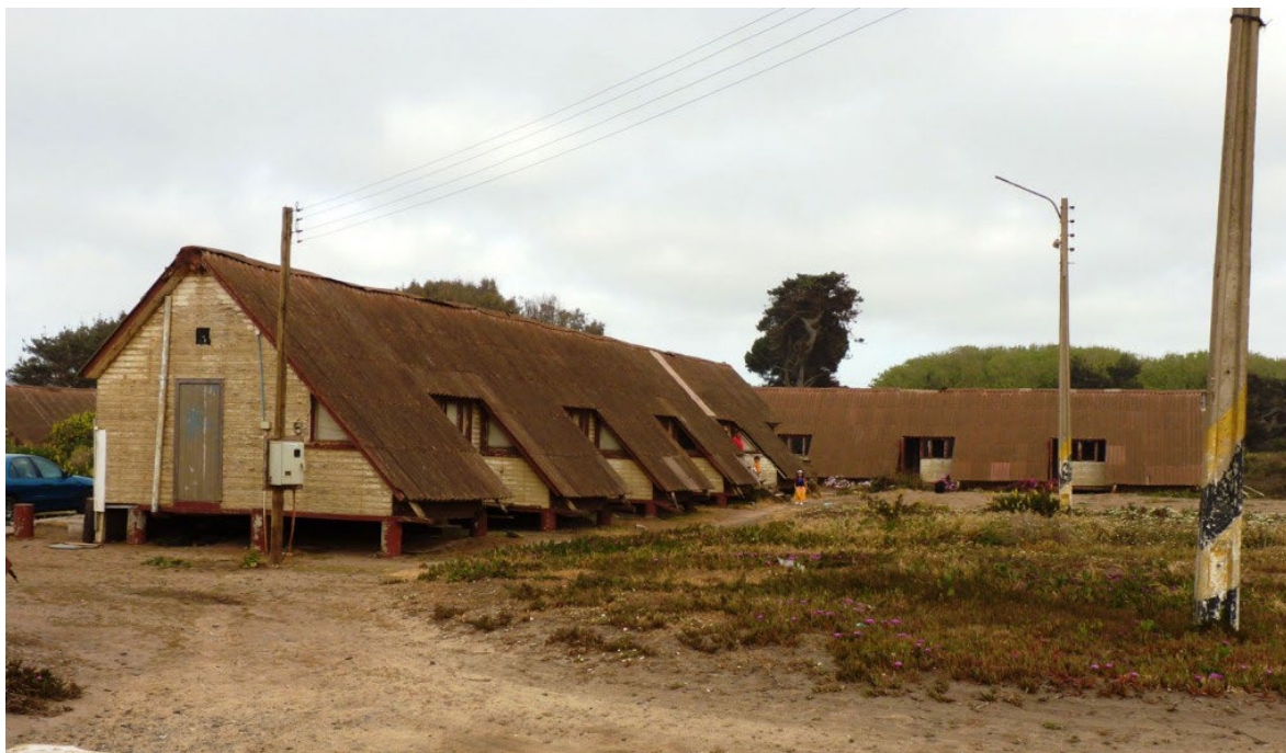
Figura 3 Fotografía situación previa a la demolición del Monumento Histórico Ex Centro de detención
