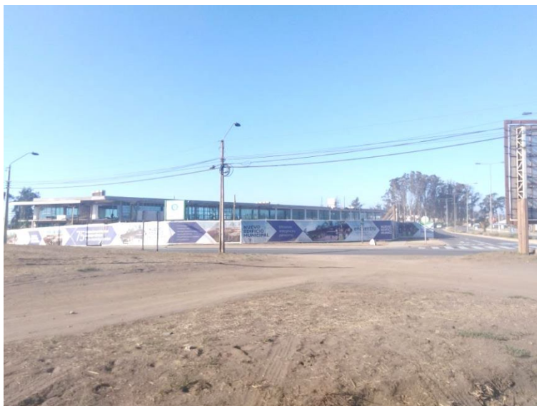
Figura 43 Construcción Edificio Consistorial sobre extensión Parque Sta. Teresa
