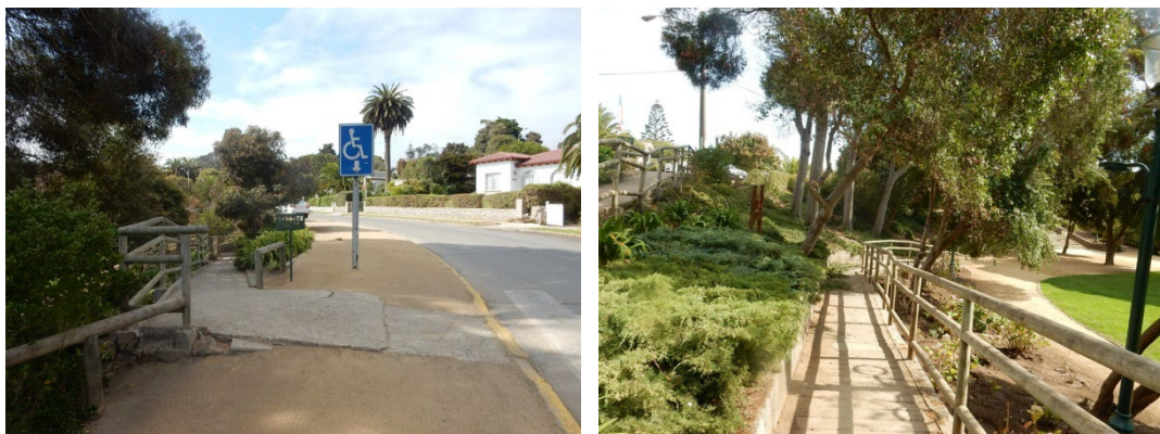
Figura 39 Acceso a través de rampas.
