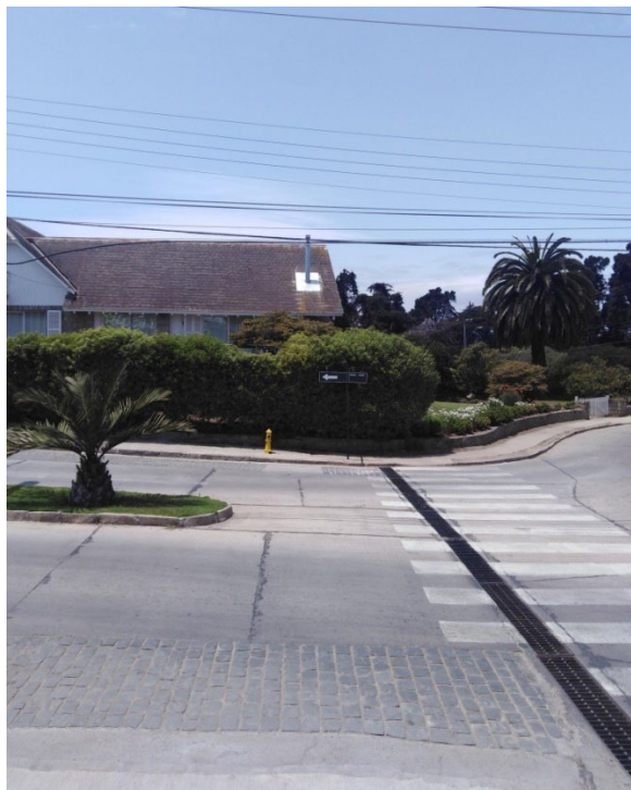
Figura 25 Av. El Parque, bandejón y empedrado.
